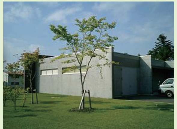
廃水処理施設全景
