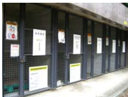
廃棄物倉庫（つくば東事業所）
