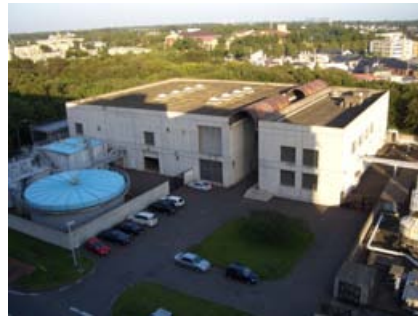
南処理場全景
