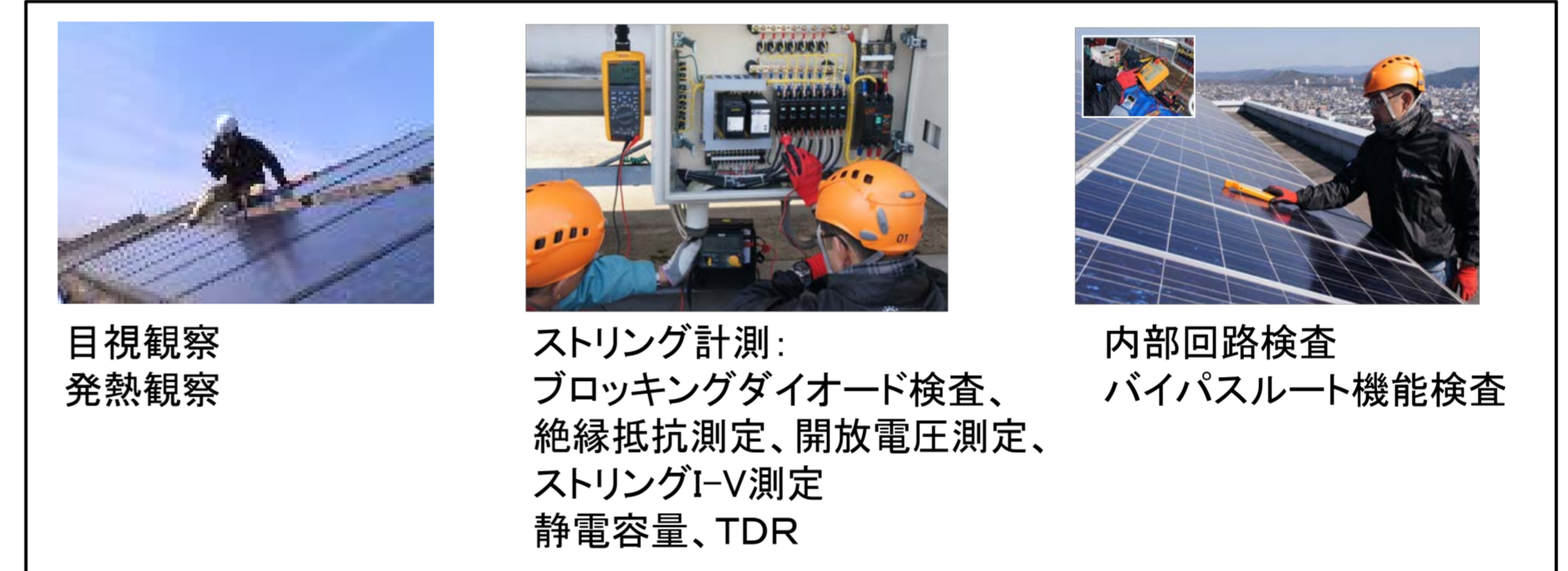
図 太陽光発電の保守点検技術
