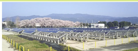
Fig. 1. 産総研九州センターの太陽電池モジュール屋外曝露サイトの全景 (佐賀県鳥栖市 [33.2°N and 130.3°E, 気候区分: Cfa]).
