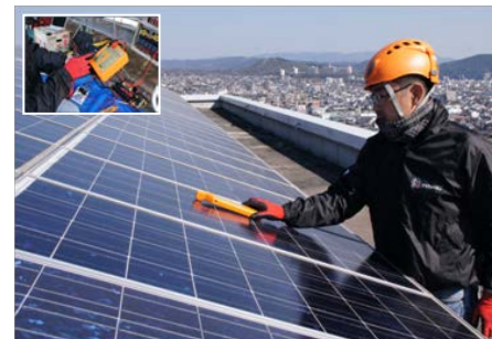
内部回路検査 バイパスルート機能検査
