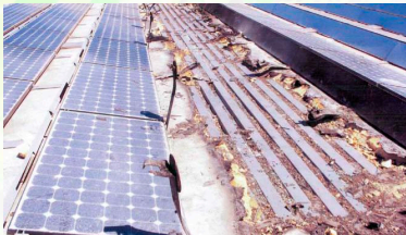
図1 米国PVシステムの火災
