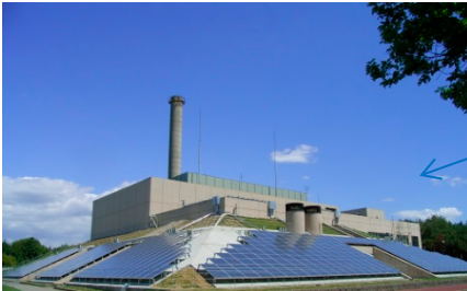
エネルギーセンター
