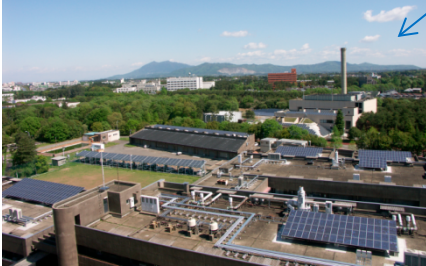
第7事業所 屋上, 駐車場
