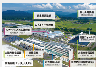
福島再生可能エネルギー研究所
