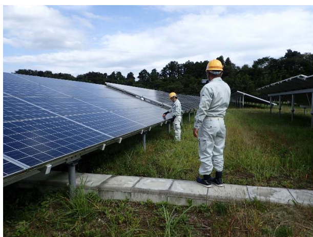
図 4.R3.1-6 配線経路を確認している様子
