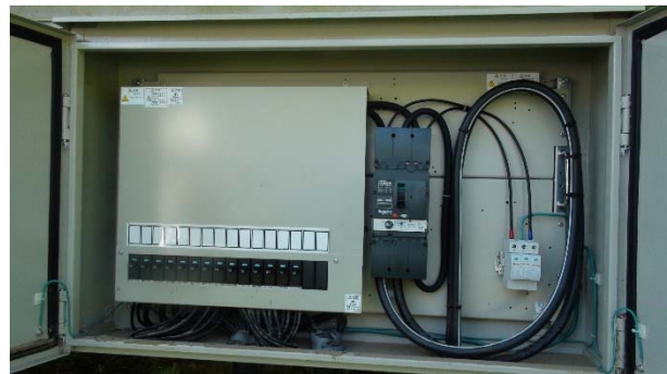
図 4.R3.3-1 接続箱の外観と内部(外蓋を開けたあと)の様子
