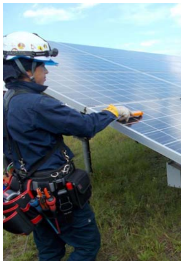
(c)モジュール表側からの探査
