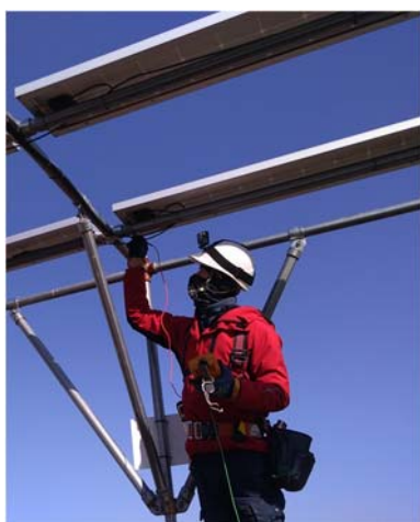
図 4.R3.11-2 等電位性の確認
