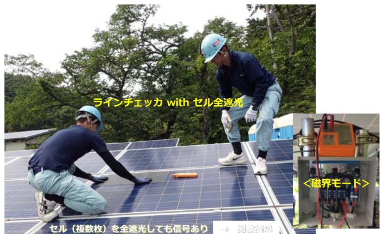
図 4.R2-25 配線路探査機による開放 BPC 検査の実施例
