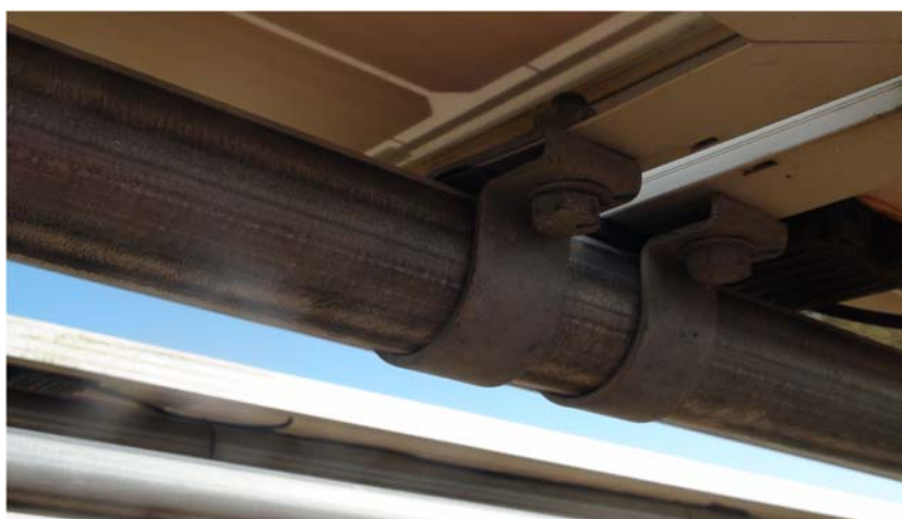
図 4.R3.11-3 モジュールと単管架台の緊結の状況
