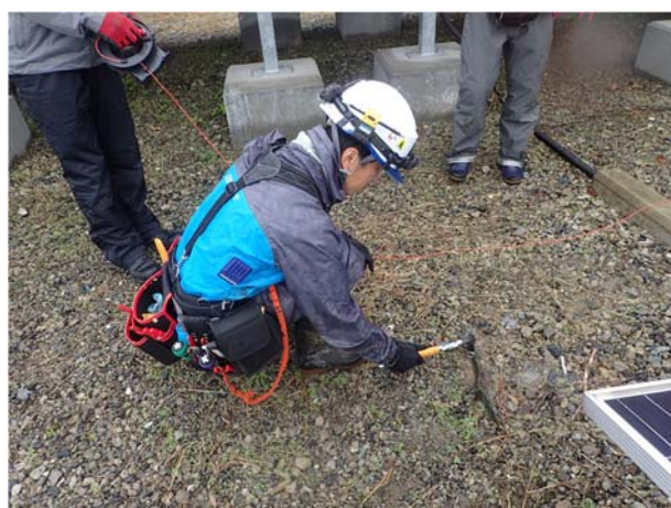
図 4.R3.6-3 補助極を打っている様子
