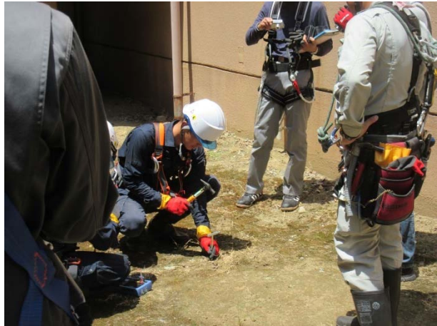
図 4.R3.7-4 接地補助極を打設している様子
