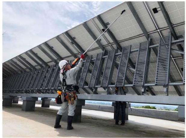
(b)受信機で信号を探査している様子
