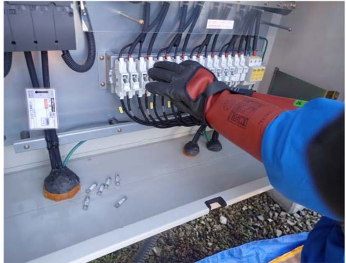
図 4.R3.6-23 ヒューズを取り外している様子
