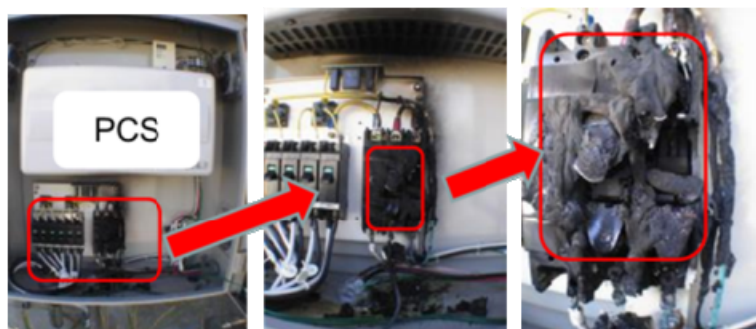
図 3.4-5 金属製における事故拡大防止例
