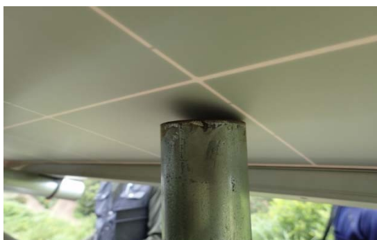
図 4.R3.5-15 モジュール裏面に接触している架台の鋼管
