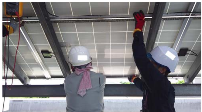
図 4.R3.7-6 モジュールフレームと架台を擦りあわせている様子
