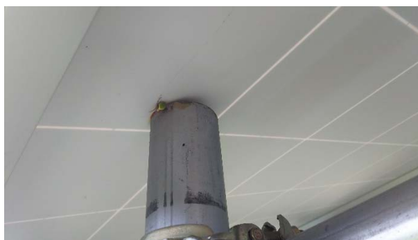
図 4.R3.5-15 モジュール裏面に接触している架台の鋼管
