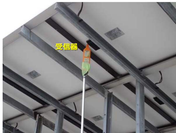
(c)断線箇所探查の様子
