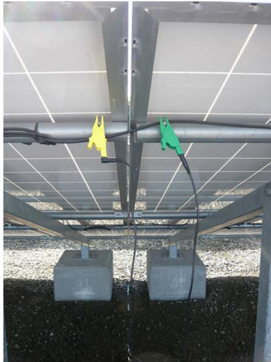
図 4.R3.6-20 リード線による架台の接続 (ストリング#08)
