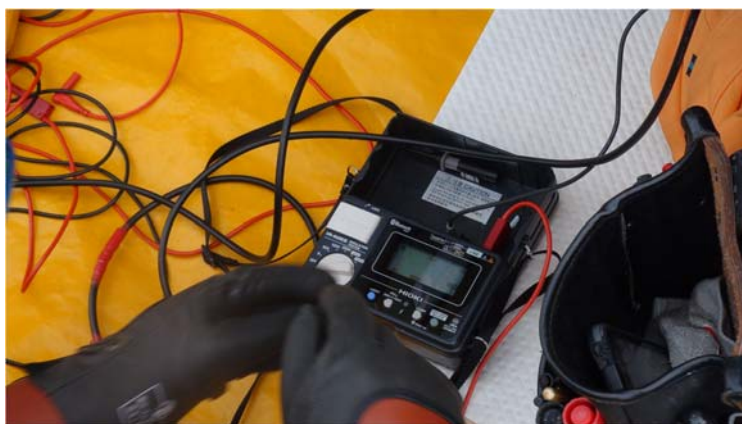
図 4.R3.6-13 絶縁抵抗計による測定
