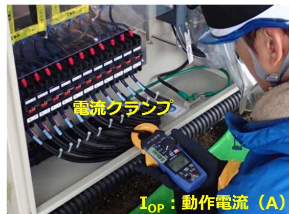
(b)動作電流の測定
