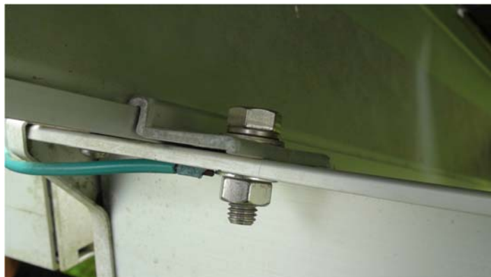
図 4.R3.2-4 取り付けなおしたストリング#11 側の金具
