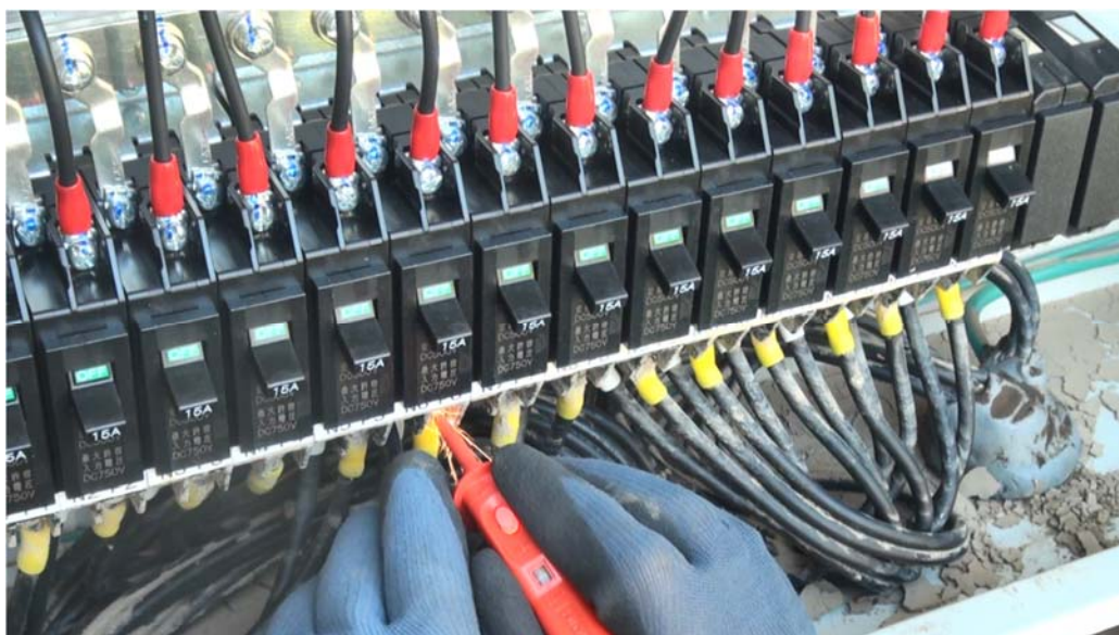
図 4.R3.3-19 測定中のスパーク発生
