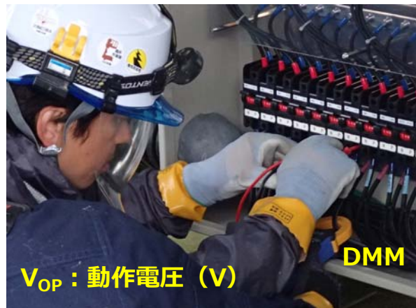
(a)動作電圧の測定
