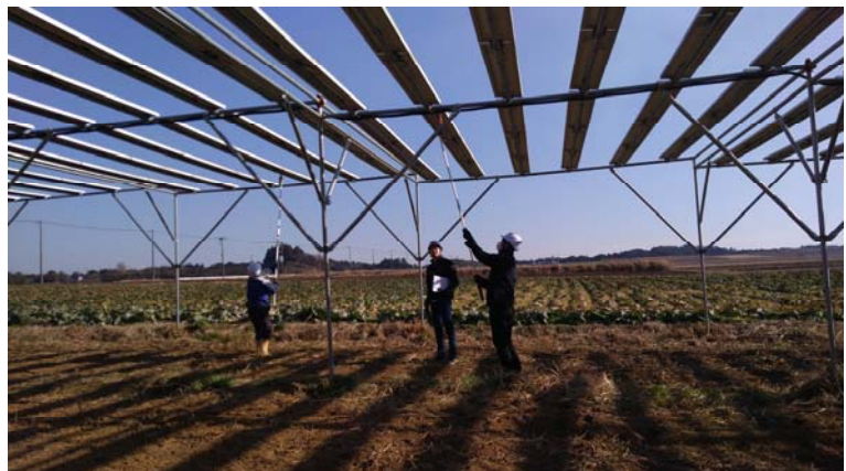
図 4.R3.11-4 配線経路の確認
