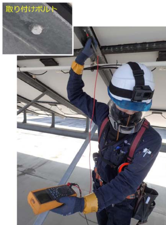
図 4.R3.10-3 等電位性の確認
