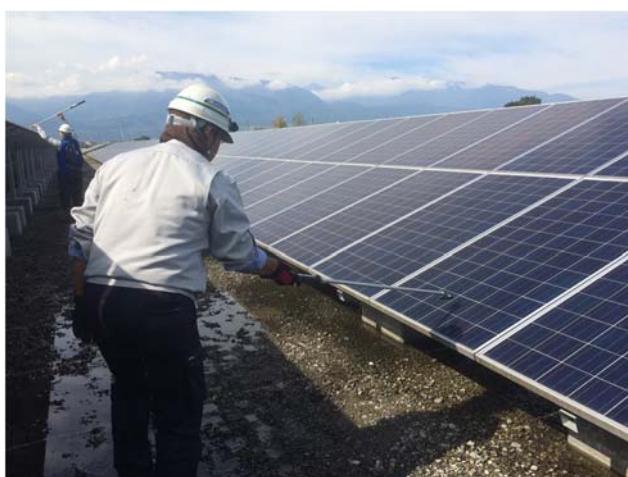
図 4.R3.6-25 ソラメンテ iS による電流探査
