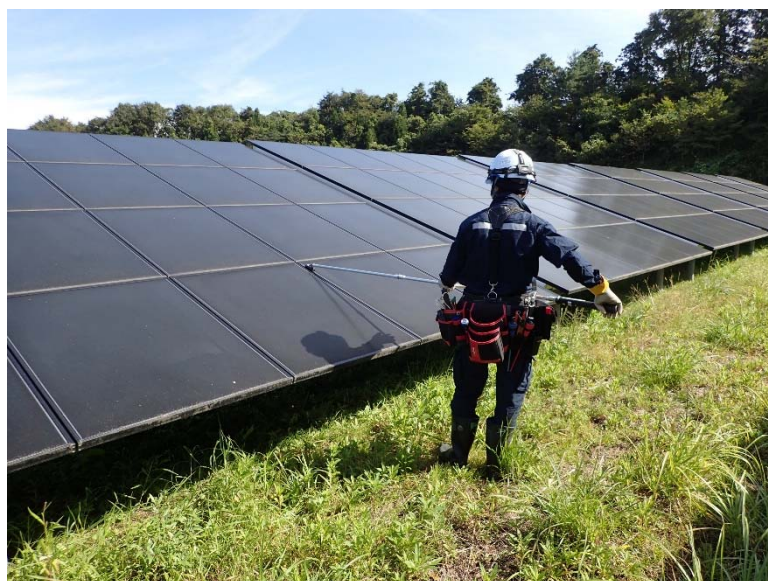
図 4.R3.2-6 ソラメンテ iS によるモジュールの通電状態確認の様子
