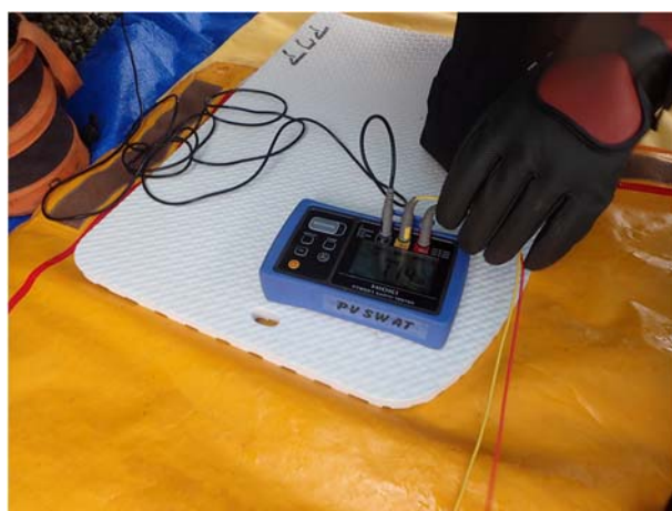
図 4.R3.6-4 接地抵抗計による測定(接続箱 A)
