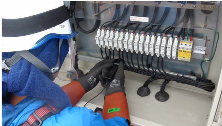
図 4.R3.6-11 スtringの漏れ電流を測定している様子(接続箱 B)
