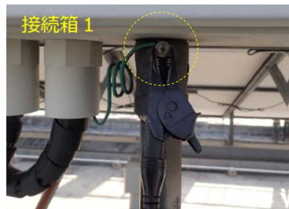
図 4.R3.10-1 接続箱#01 の接地極
