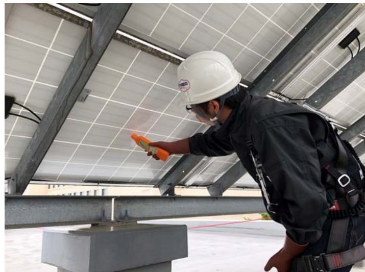
(d)モジュール裏側からの探査
