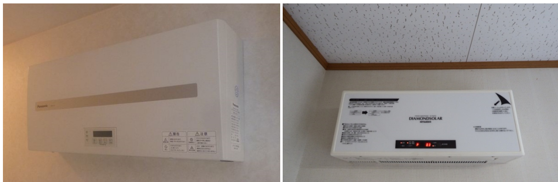
図 1-10 パワーコンディショナーの例 3
