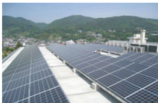
図 2-4 屋根置き型例
