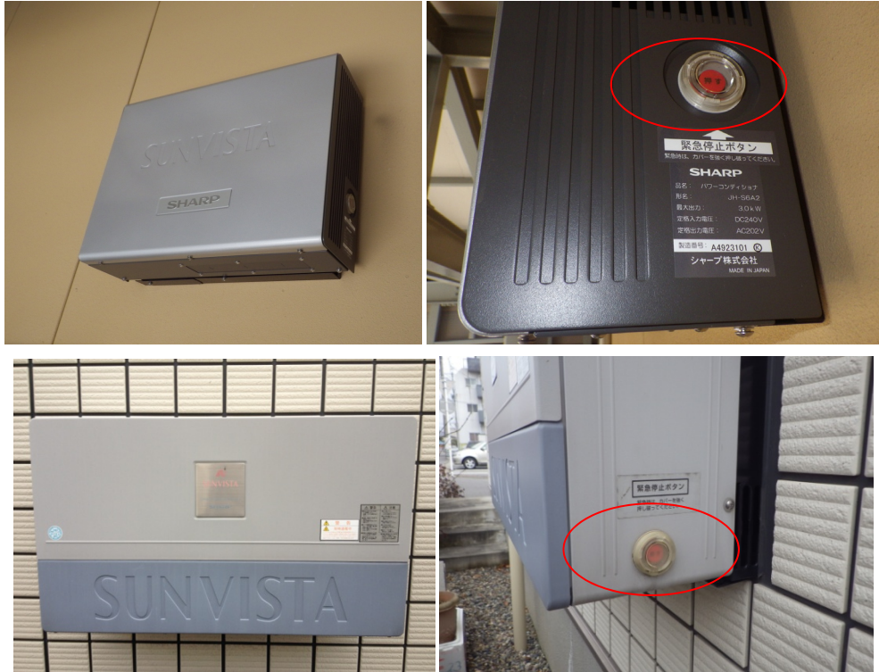
接続箱・パワーコンディショナー一体型 停止ボタンの例
