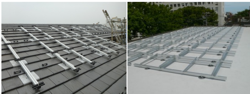
図 1-8 架台の例 3
