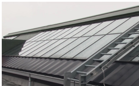
図 2-12 太陽熱利用システム設置例 14
