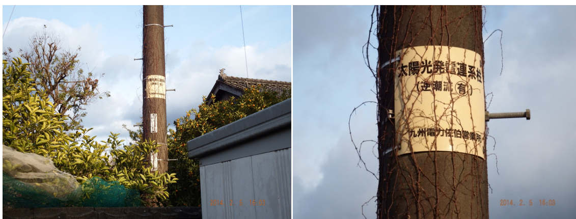
例 2 電柱における目印の例 17
