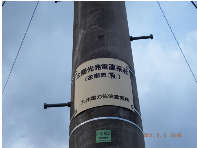
例 3 電柱における目印の例 2
