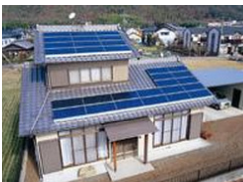
図 2-4 屋根置き型例
