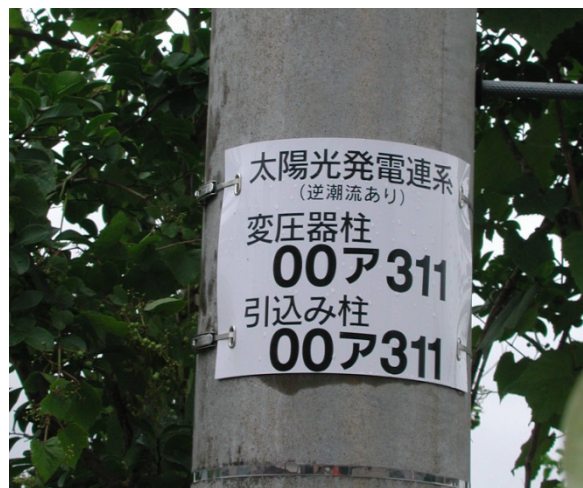
例 4 電柱における目印の例 1
