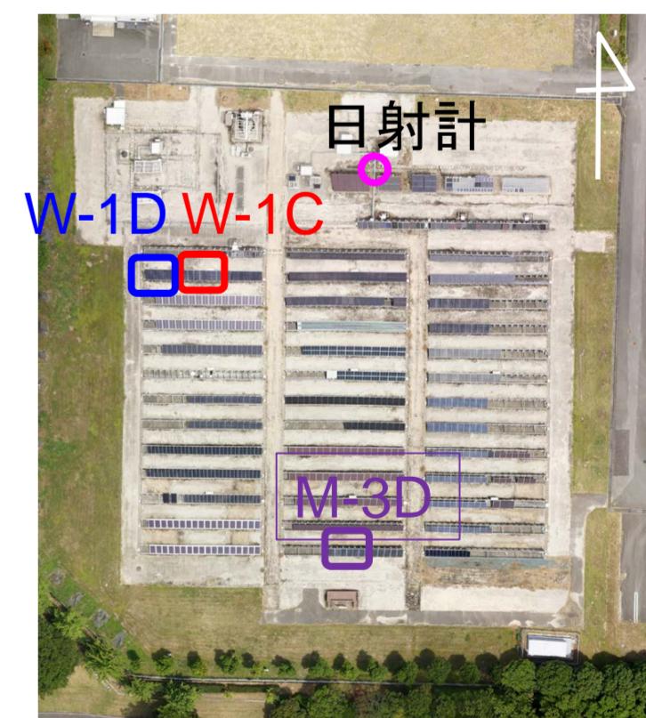
図4. ドローン撮影による曝露サイトの全景。(W-1C、W-1D、M-3Dおよび日射計の位置)
