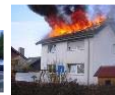
PV付建物火災
