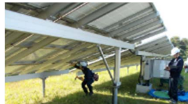
等電位ボンディングの確認の例
