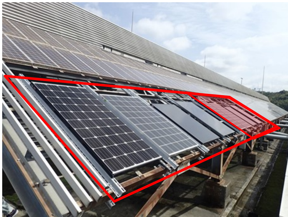
洗浄システムを設置したモジュール位置 (赤いハッチング部が洗浄システム有) (手前4枚は、そのままの状態)
