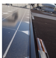
図8 入射角が大きい時、アルミフレームが作る陰
