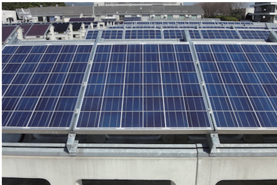
各種ポリマー薄膜導入モジュール (部分的に導入)
