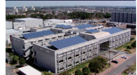
第2事業所OSL 屋上, 壁面
