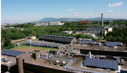
第7事業所 屋上, 駐車場
