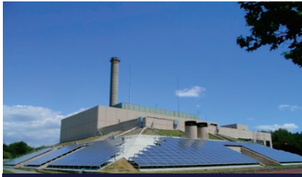
エネルギーセンター
