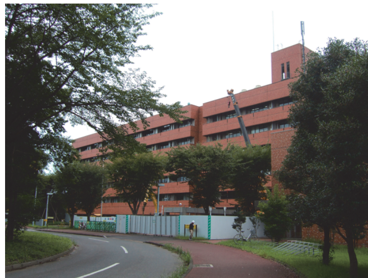
第5事業所：化学設備を完備した 有機系太陽電池の開発拠点
