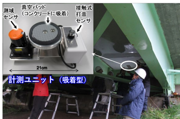
吸着型小型計測ユニットを用いた床版裏での打音検査実験の様子
