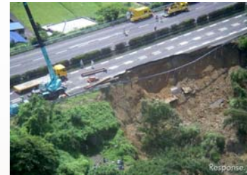
<2009年8月静岡県沖地震により東名高速牧の原地区盛土斜面崩壊> ( http://www.hido.or.jp/djvrousel_backnumber/2009data/0911/0911tokushu-toumei-saigaitaiou.pdf )
