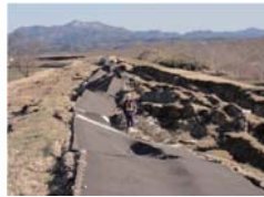
<2013年東日本大震災・阿武隈川堤防の被害> ( http://k-keikaku.or.jp/cc/modules/pc_ktech/index.php?content_id=2103 )
