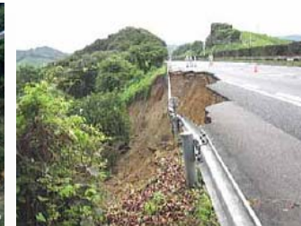
<2009年8月静岡県沖地震により東名高速牧の原地区盛土斜面崩壊> ( http://www.hido.or.jp/djvrousel_backnumber/2009data/0911/0911tokushu-toumei-saigaitaiou.pdf )
