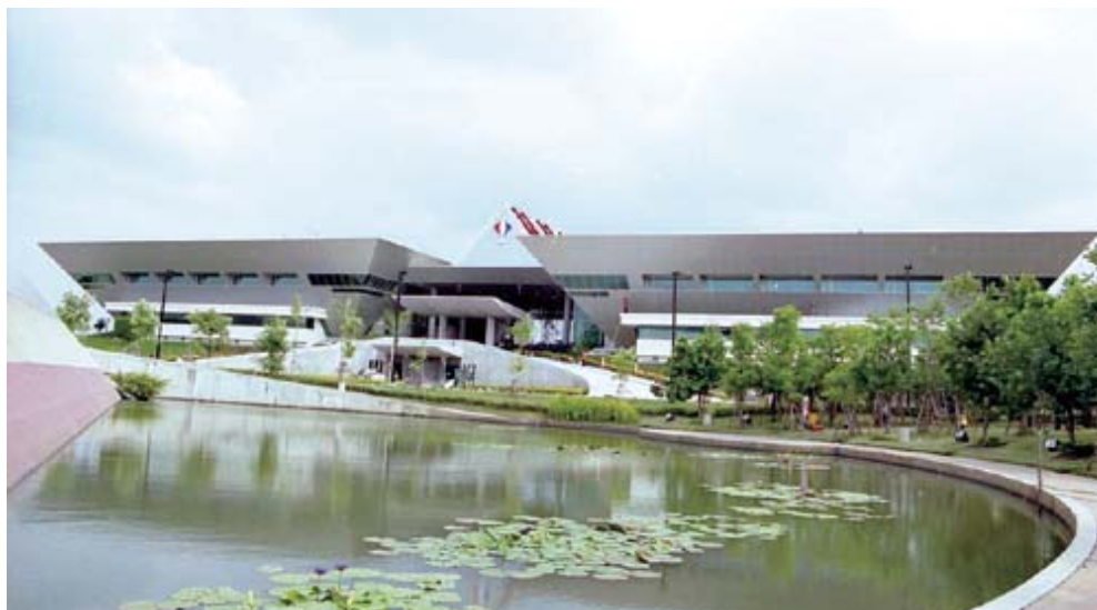
図 33 工事終了直後の新庁舎（2005 年 5 月）
