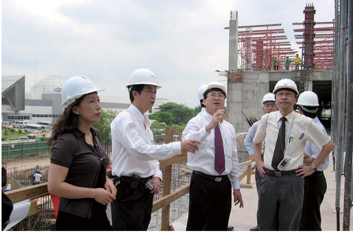
รูปที่ 18 กลุ่มสำรวจได้รับการบรรยายสรุปเกี่ยวกับอาคารห้องปฏิบัติการแห่งใหม่ ในระหว่างการก่อสร้าง โดยมี นายสมศักดิ์ ฉากเขียน (คนกลาง) เป็นผู้อธิบาย
