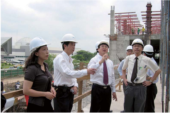
รูปที่ 18 กลุ่มสำรวจได้รับการบรรยายสรุปเกี่ยวกับอาคารห้องปฏิบัติการแห่งใหม่ ในระหว่างการก่อสร้าง โดยมี นายสมศักดิ์ ฉากเขียน (คนกลาง) เป็นผู้อธิบาย
