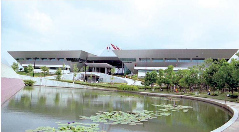
รูปที่ 33 อาคารห้องปฏิบัติการแห่งใหม่ที่เพิ่งแล้วเสร็จ (พฤษภาคม 2548)
