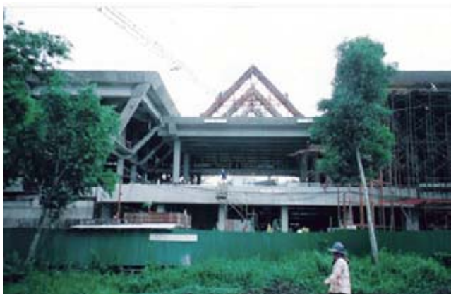
図 17 吹き抜け構造の玄関棟
