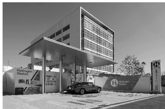
図4 水素ステーション(水素ST)の一例 (@ 岩谷産業株式会社 掲載許可済み) 21)
