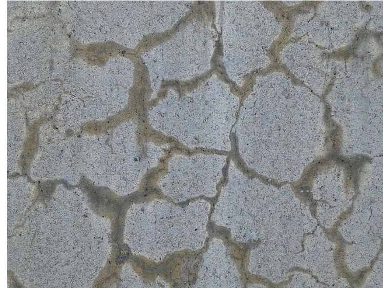
アルカリ溶液との反応で骨材が膨張
