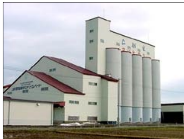
カントリーエレベーター
