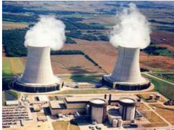
発電プラント
