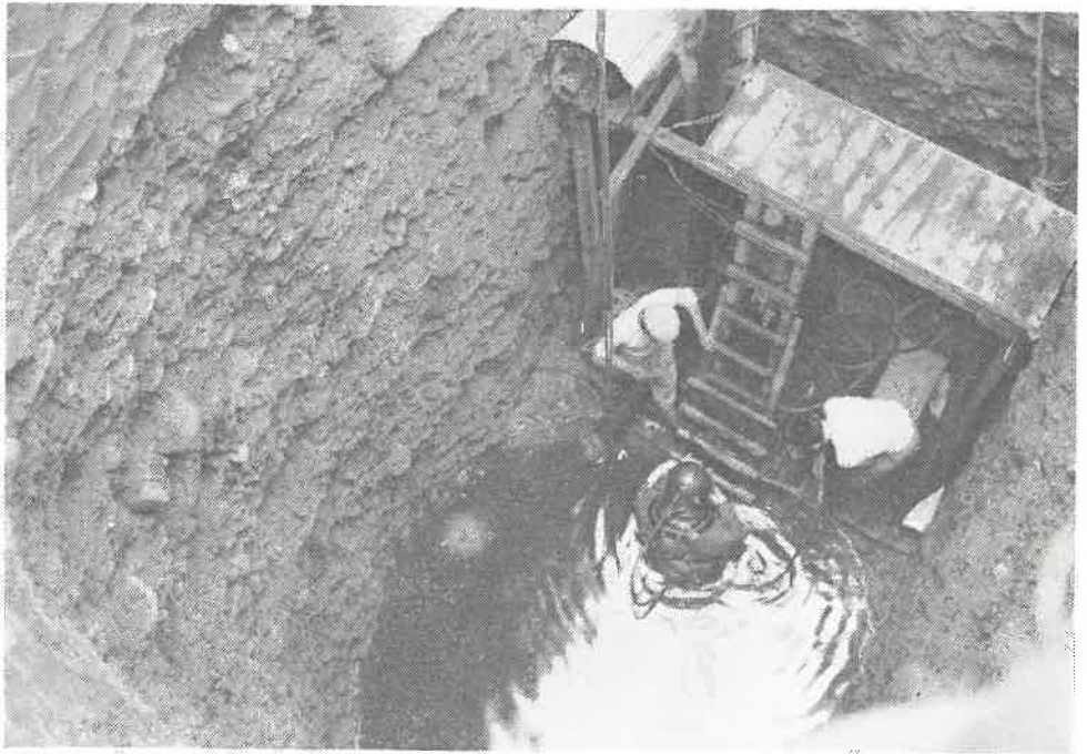
写真-22(b) 地下水量豊富なため、ポンプでは汲み切れず (5,000~10,000トン/日) 潜水夫による井戸堀り (西那須野町水道水源)
