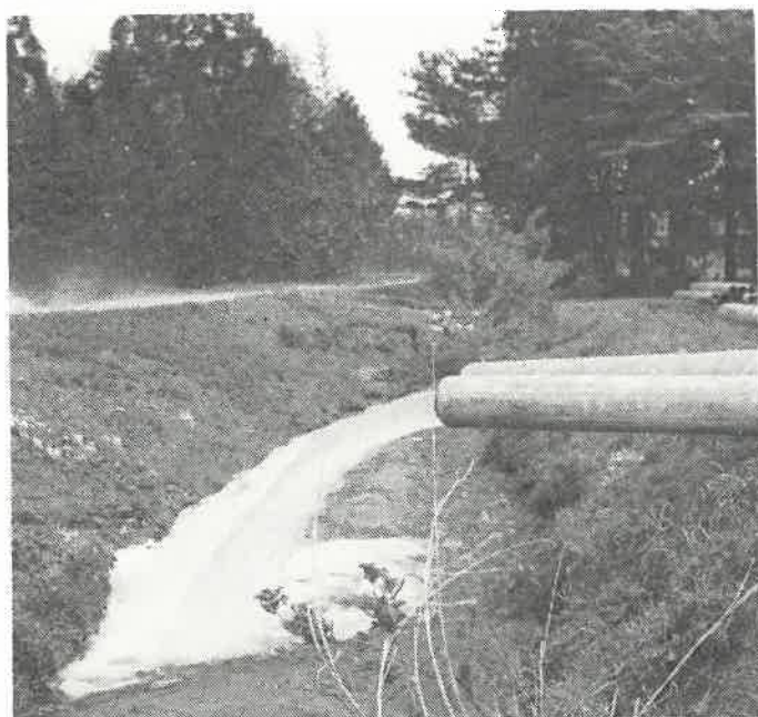
写真-22(d) 地下水揚水試験
