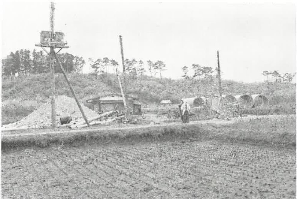
写真一25 井戸堀り現場西那須野町 烏が森（西那須野水道水源）
