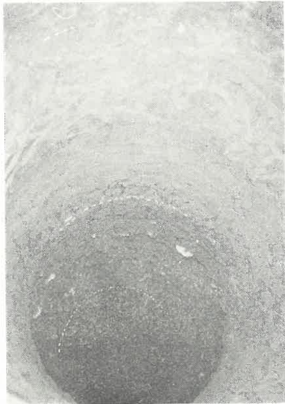
写真一11 井戸の内部 上部より 黒土→那須ローム →扇状地れき層→ 鳥の目れき層(茶 色)
