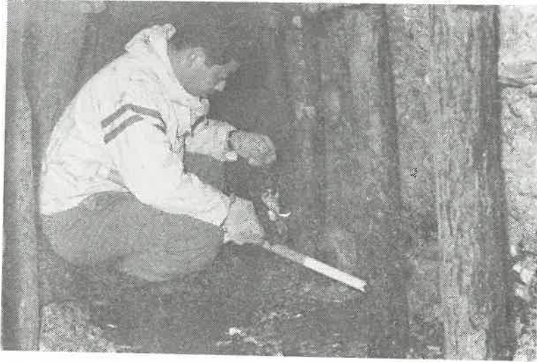
写真一⑤ 横井戸掘さくによる水口の変化の確認
