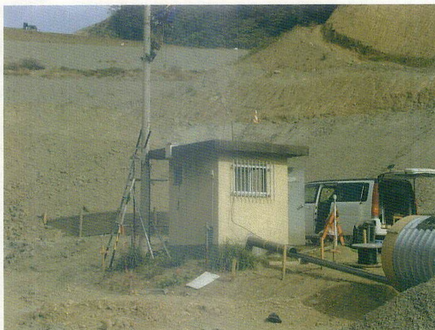
写真1 観測井の現況(11月20日現在)
