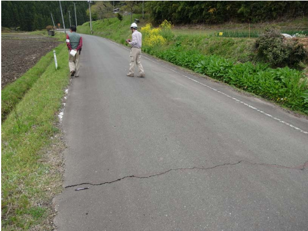
写真 17 : 遠野町入遠野越台の南南東 0.4km ( 37^{\circ} 3.22' N , 140^{\circ} 41.60' E ) 井戸沢断層の北方延長に当たる地点で、道路を横切る NW-SE 方向の幅 30m の断層帯が認められた。
