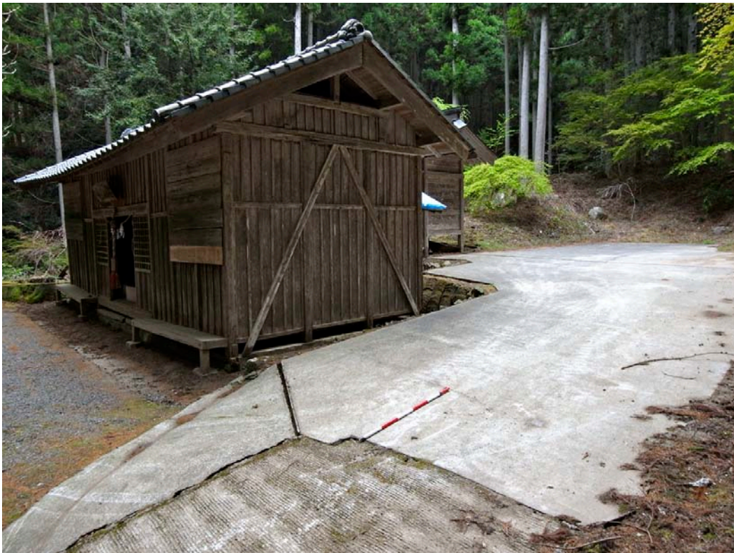
写真 4 : 遠野町入遠野東山の北東 0.5km (37° 3.16' N, 140° 43.03' E) 大山祇神社脇ので、幅 15m 以上にわたってコンクリート舗装が破損. 3 条の亀裂に水平伸張と左ずれ.
