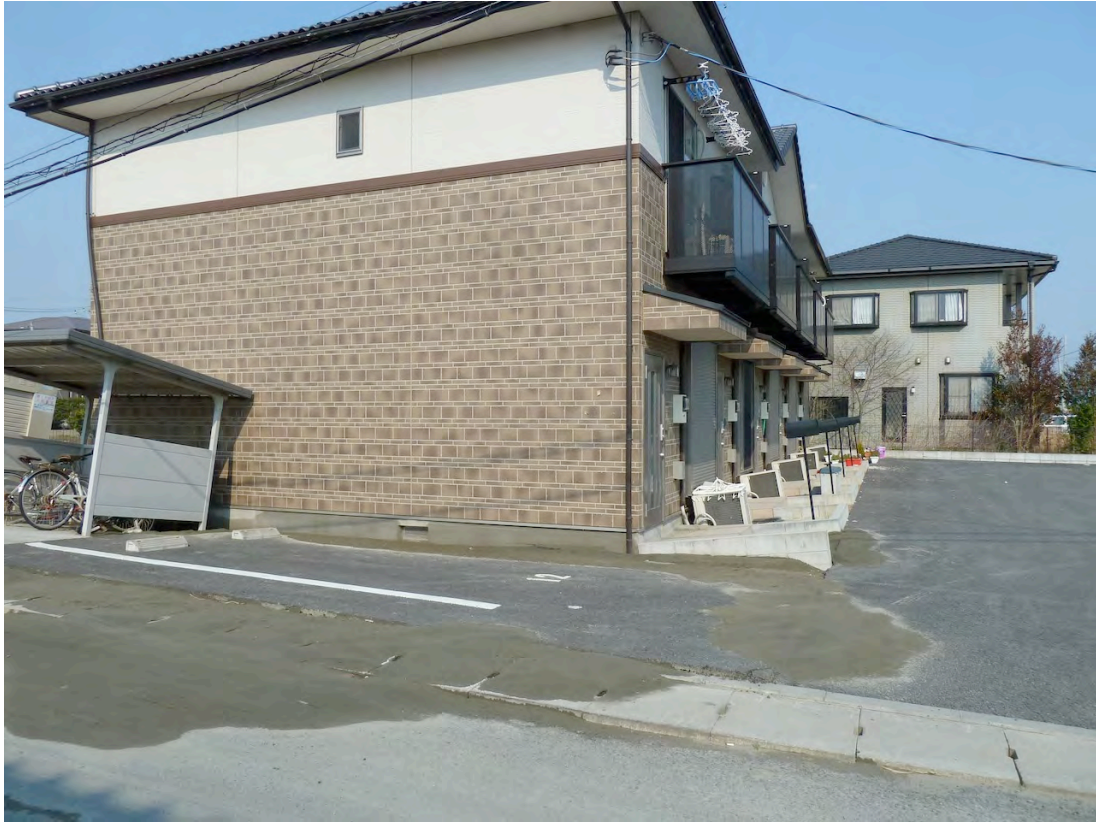
家屋の沈み込みと砂の押出し。沈下し傾斜した家屋が地区一帯にみられる。
