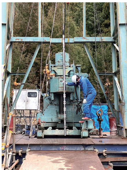
写真 2 紀北海山観測点の孔 4 のボアホールひずみ計の埋設作業。
