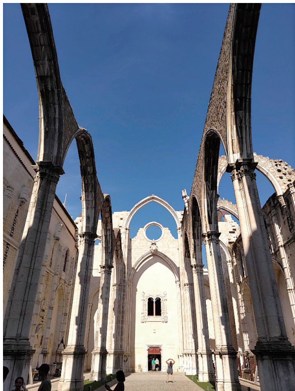
写真5 1755年の地震（リスボン地震）で崩落したカルモ修道院。崩落した天井などもむき出しの状態のまま保存、展示されていました。
