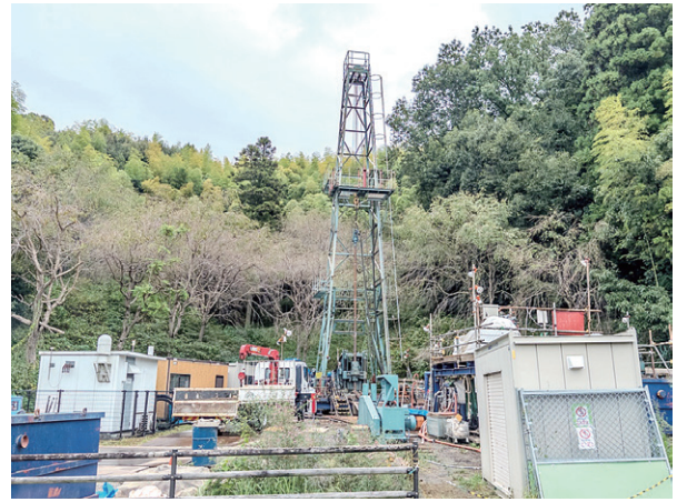
写真1 阿南桑野観測点での観測井戸の掘削の様子.
