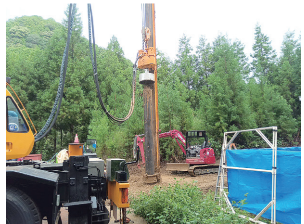
写真2 紀北海山観測点での現地作業開始の様子. (住鉱資源開発株式会社 中村勇亮氏提供)
