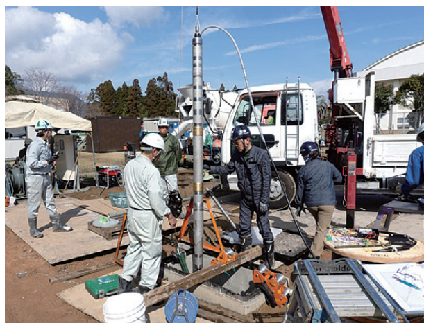
写真3 孔2の地震計の埋設作業.
