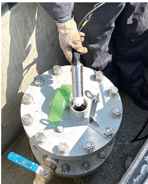
写真 5 孔 3 の水位計の設置作業。
