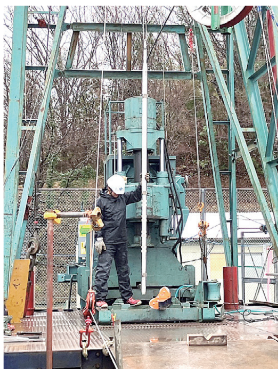
写真2 孔1のボアホールひずみ計の埋設作業.
