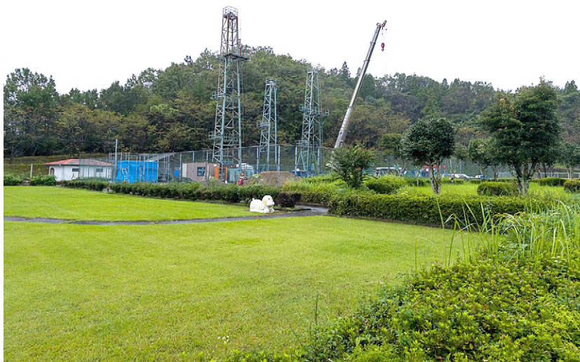
写真1 掘削準備時の写真。
