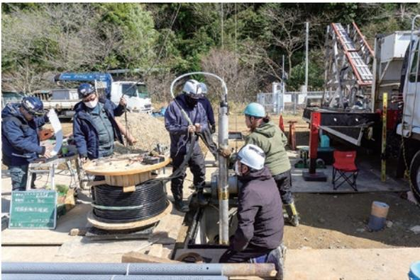
写真3 孔2の孔底地震計の設置作業。
