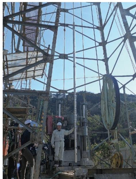
写真 2 孔 1 のひずみ計（デジタル式地殻活動総合観測装置）の埋設作業
