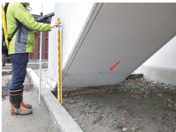
写真2 津波の浸水状況調査．建物壁面のウォーターマークを赤矢印で示す．（地質調査総合センター公式HPより）
