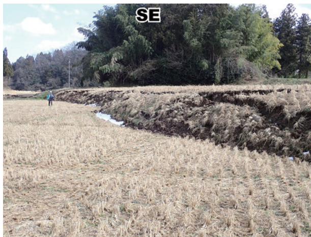
写真3 地表変状調査．珠洲市若山町中（なか）の水田に生じた南側上がりの落差．南東に向かって撮影．人物の身長は約180cm．（地質調査総合センター公式HPより）
