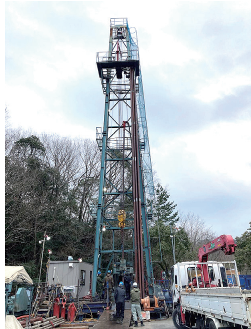
写真1 綾川千疋観測点の孔1の掘削作業。
