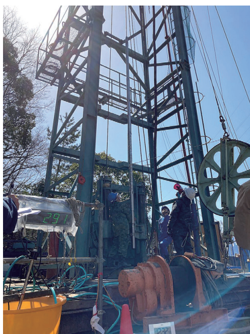
写真4 孔1のデジタル式地殻活動総合観測装置の埋設作業。
