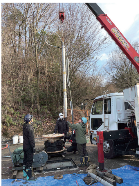
写真3 孔2の地震計の設置作業(矢部優研究員提供)。
