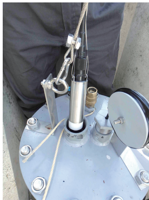
写真5 孔3の水位計の設置作業(北川有一グループ長提供)。
