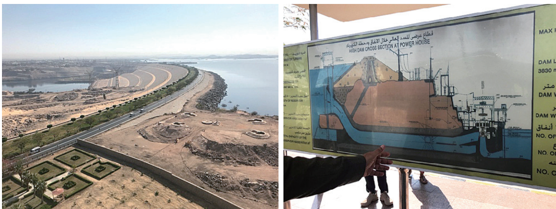
写真3 アスワンハイダム堤体の全景と断面図(ナイル川の全ての水は堤体下部の6本の管路を通る)。
