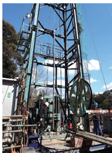
写真 2 デジタル式地殻活動総合観測装置の埋設作業風景。
