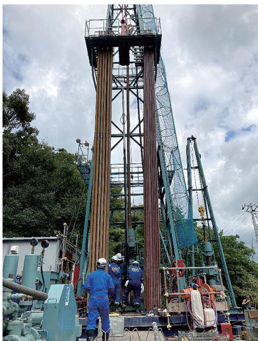
写真1 孔2の速度検層の実施状況。
