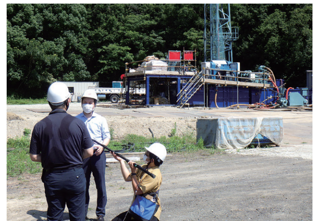
写真2 板場智史主任研究員へのNHK和歌山放送局による掘削開始の取材の状況（板場智史主任研究員提供）
