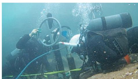
写真6 足摺岬での水中ボーリング掘削。
