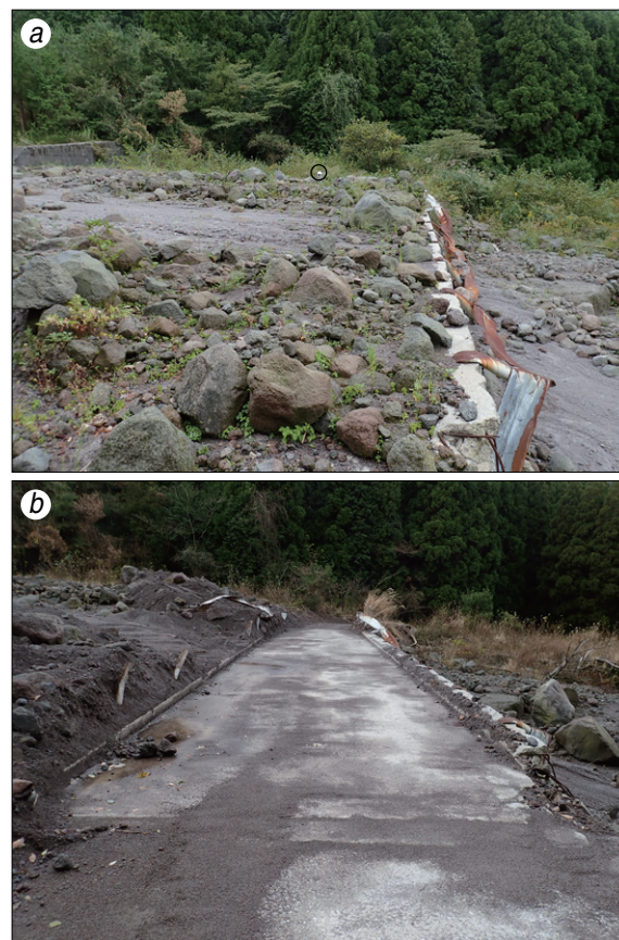
図3 a) 砂防堰堤から溢れ出た大量の巨礫や土砂で覆われた地点1における林道Bの状況（2019年10月12日撮影）。横倒しになったガードレールがあることでわかるようにこの近くに道路があることがわかる。写真中央やや上寄りでスケールとして置いたヘルメットを○で囲む。b) 重機を用いて巨礫や土砂を取り去ったことによって現れた地点1の舗装された林道B（2019年12月19日撮影）。
