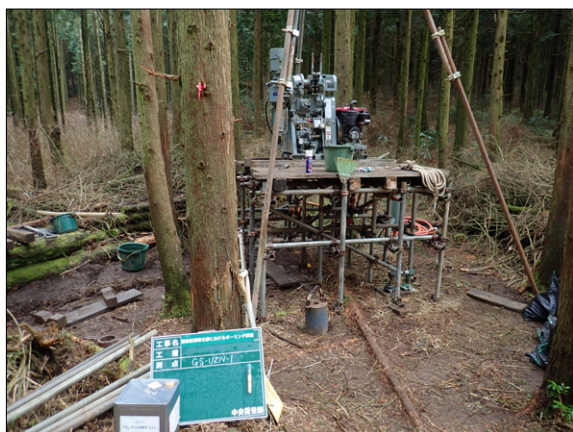
図5 国有林野内でのボーリング調査風景。密集する木と木の間の狭いスペースに足場を設置してボーリング掘削を実施（2020年1月24日撮影）。
