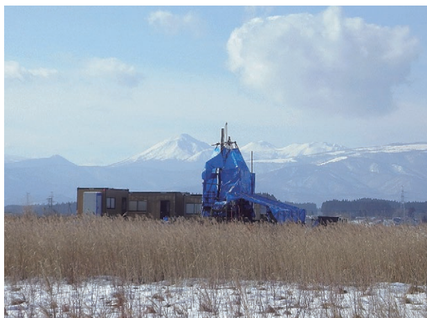
図 2 上北ボーリング掘削現場の遠景 後方に見えるのは八甲田山。（撮影：佐藤努氏）
