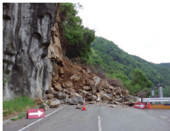
写真2 崖崩れでふさがれた道（美里町）。このむこうに調査したい湧水があります。3方向からアクセスを試みましたが、どのルートもふさがれていました。峠の反対側にもう1つのルートがあったのですが、時間が足りずに調査を断念しました。（撮影：佐藤 努）
