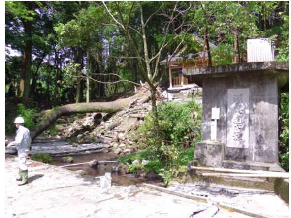
写真3 地震で被害を受けた湧水（潮井水源）。徒歩のみでアクセス可能になっています。以前は、右側の掛樋から水が出ていました。（撮影：佐藤 努）
