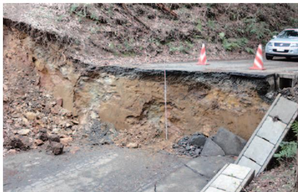
図 5 2011 年福島県浜通りの地震 (Mw=6.6) で地表に露出した地震断層 (井戸沢断層の一部). 写真手前側 (上盤) が西で奥側 (下盤) が東です. この断層は手前側が西へ落ちる正断層です. 地震発生後の道路復旧工事により, 現在はこの断層露頭は観察できません.
