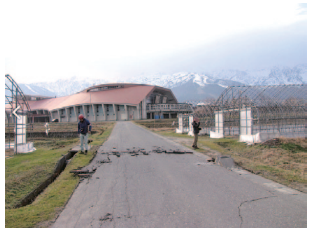
写真3 白馬村深空集落東の舗装道路にみられる、11月22日の地震に伴う短縮変形（11月25日撮影）。GSJホームページ（ https://www.gsj.jp/hazards/earthquake/naganokenhokubu2014/naganokenhokubu20141126.html ）より。
