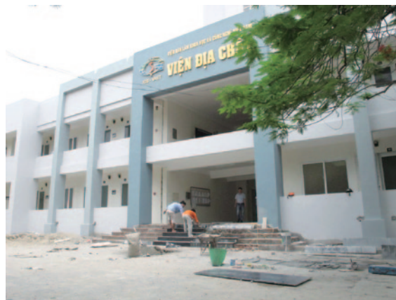
写真5 首都ハノイにあるVASTの地質関係の建物の入口（工事中）。建物は改装工事と新しい分析装置の導入が急ピッチで進んでいます。
