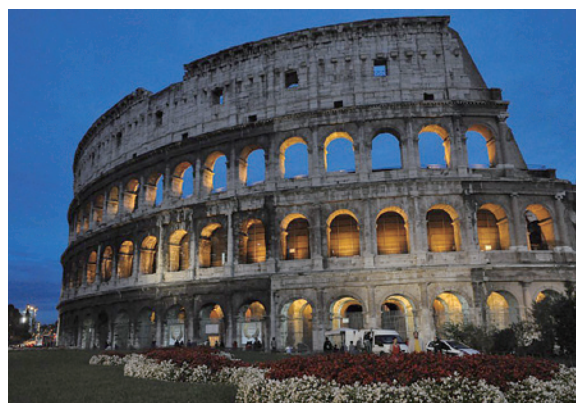
写真3 毎日その横を通って通勤していたおなじみのコロッセオの夕景。半分崩れたコロッセオにも地質学的な理由がある。固結した段丘層を基盤としている北半分は高さ 50 m に及ぶローマ時代の外壁がほぼ完全に残っているのに対し、開析谷を埋めた軟弱地盤の上に建てられた南半分は中世に起こった数回の地震で崩壊し、ほとんどその原形をとどめていない。
