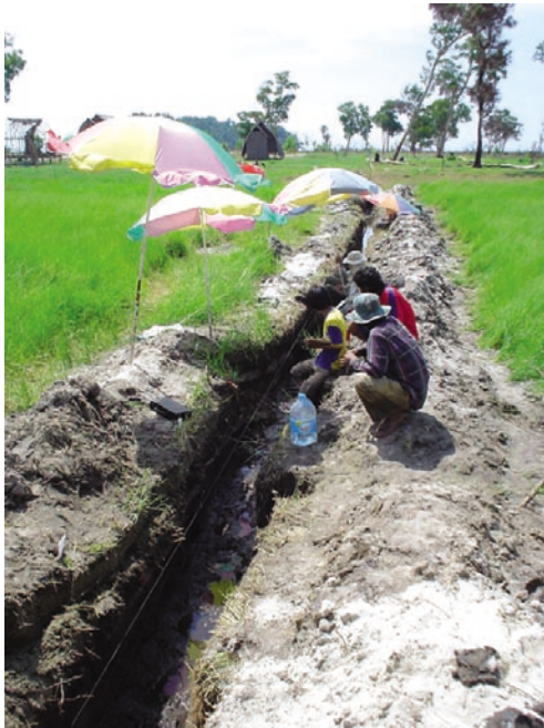
プラトン島でのピット掘削風景。
